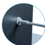
Estetycznie wykończone okablowanie
